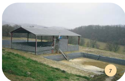
Séparateur de phase avec fumière couverte fosse.
