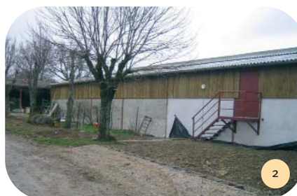
Vue du long-pan Nord avec l'accès à la plateforme de surveillance des animaux.
